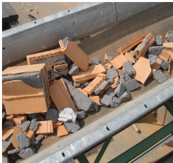
Der Ziegelbruch gelangt über ein Förderband zum Backenbrecher und dann weiter zum „Windsichter“.
