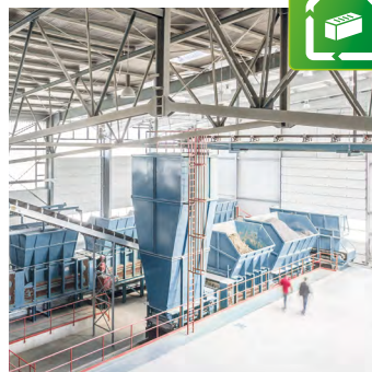
Aus Baustoff wird Wertstoff. Echte Kreislaufwirtschaft durch Rückführung des recycelten Materials.
